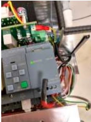
Kabelbaum an der Steuerung anschließen
